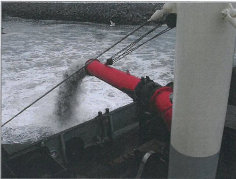
Figur 3-6: Eksempel på utspyling av rene sand- og grusmasser med M/S Gerd Stensen.
