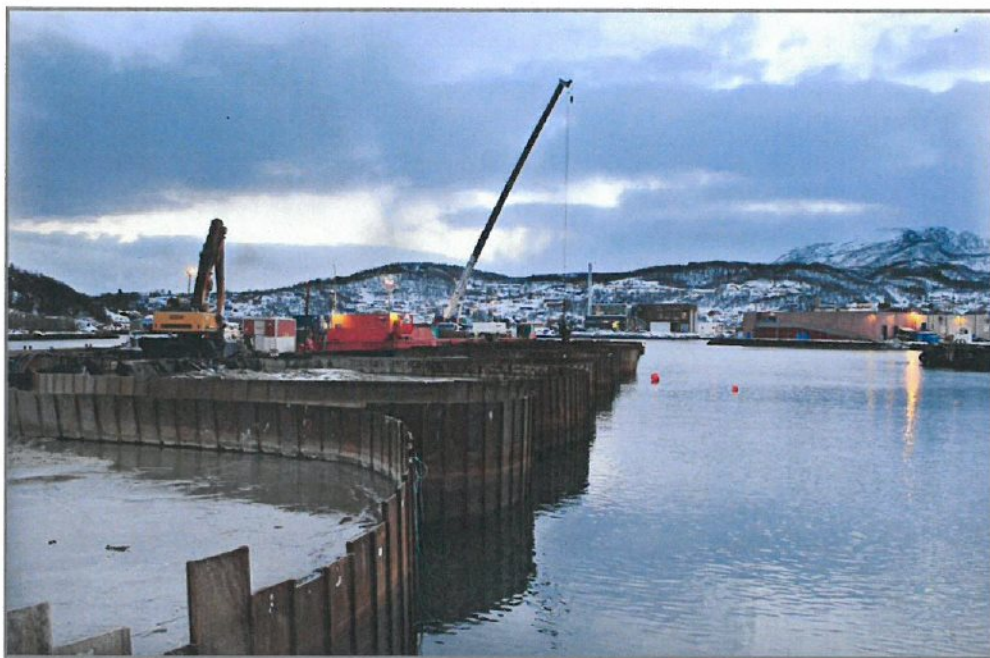
Figur 3-3: Vannstanden inni cellene er høyere enn utenfor ved fallende tidevann. Kilde: Kystverket.
